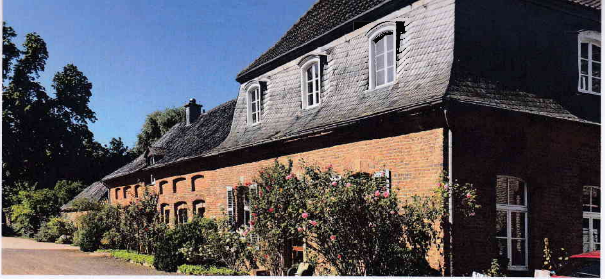
Abb. 1: Haus Bollheim, Wohnhaus
